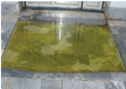
شکل ۱۱-۱- تعبیه حوضچه ضدعفونی در مدخل سالن مرغداری
